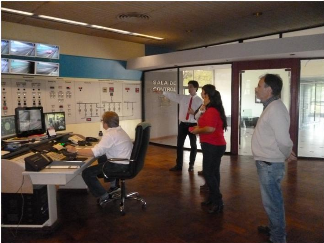
Túnel Subfluvial Hernandarias. Visita técnica
