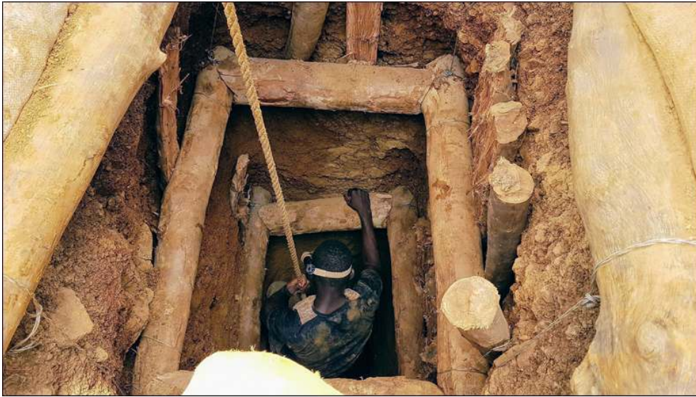
Illustration 7 - Cadre de soutènement en bois d'une galerie typique des mines artisanales au Burkina Faso
